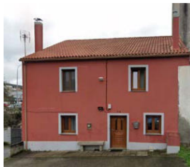
Edificación existente NO compatible
