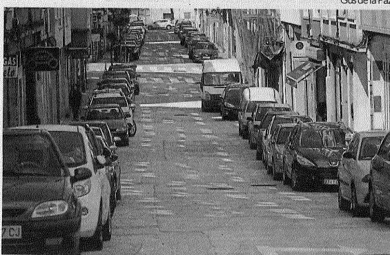
Vista de la calle Pascual Veiga tras las obras.
