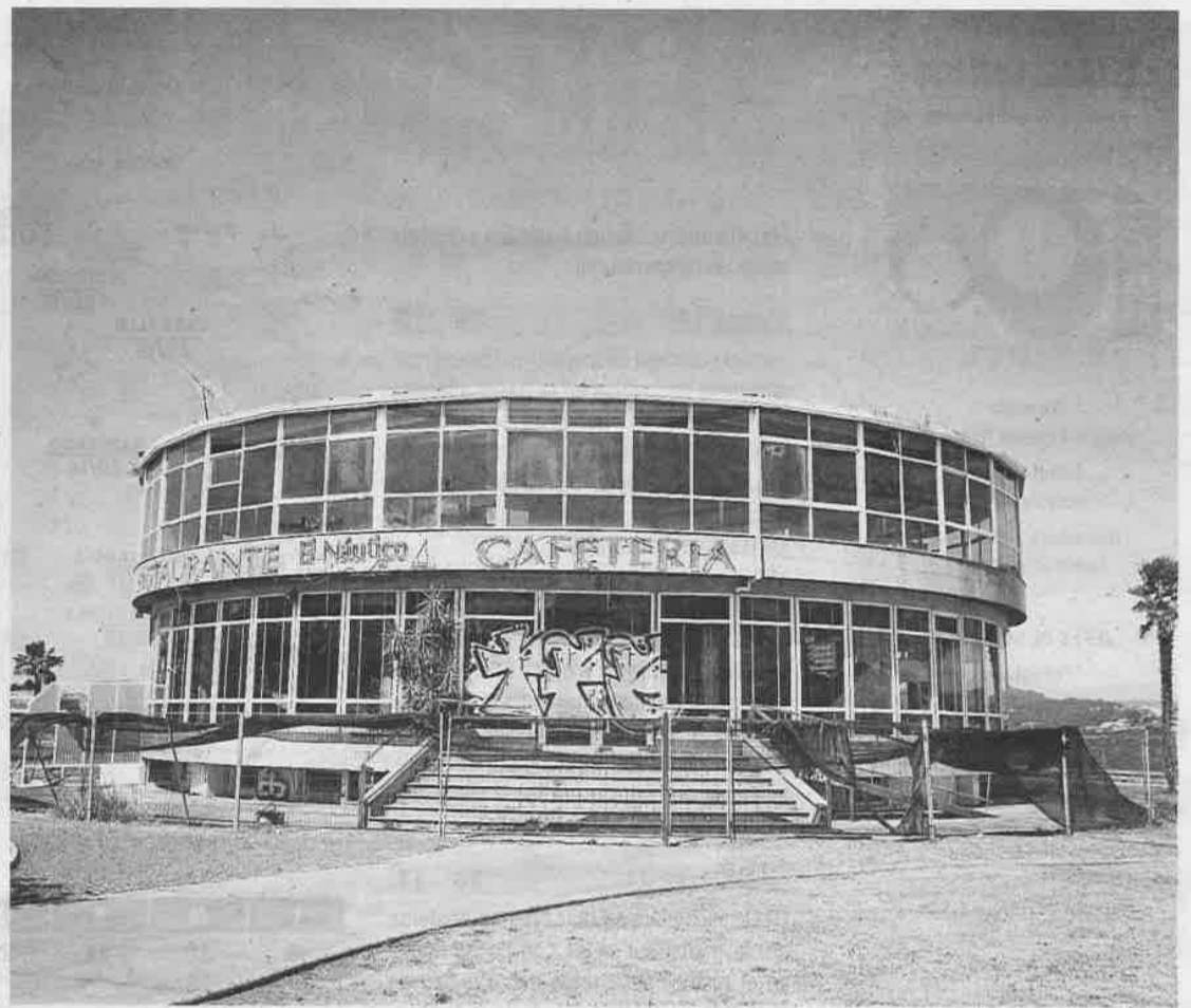
El edificio municipal del Náutico | PATRICIA G. FRAGA
